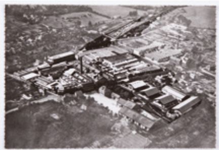
L'ancienne teinture Marot réhabilitée en centre d'art contemporain
